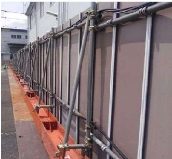
鋼製万能板 H 型鋼設置例
