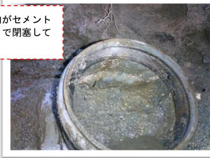
既製杭打設時に既設配管（下水道枝管）の養生が不十分であったため、セメントミルクが配管内に流入し、下水道本管まで詰まらせてしまった。
